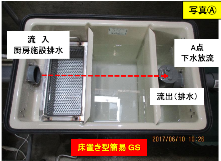
比較表1 ■GS流入原水ノルマルヘキサン濃度730 mg/Lを140L連続注水 ※4.6L/分
